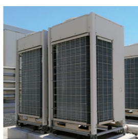
コンプレッサー
