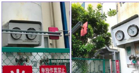
【外部設置のCEタンク用：防水機能（IP65）】
