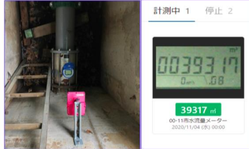
市販のスマホ用 望遠レンズ装着で遠い位置にある計器も読取OK
